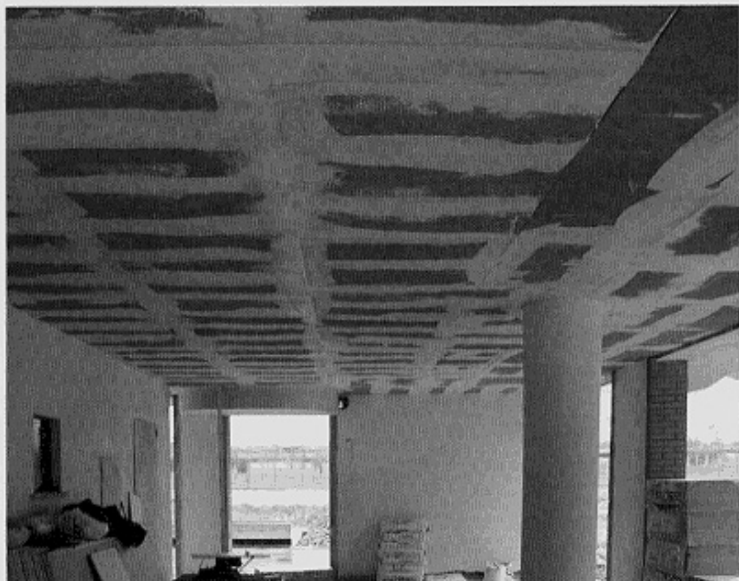
Esecuzione cappotto esterno di un portico con pannelli in sughero bianco naturale supercompattato SokoTerm.LV.
