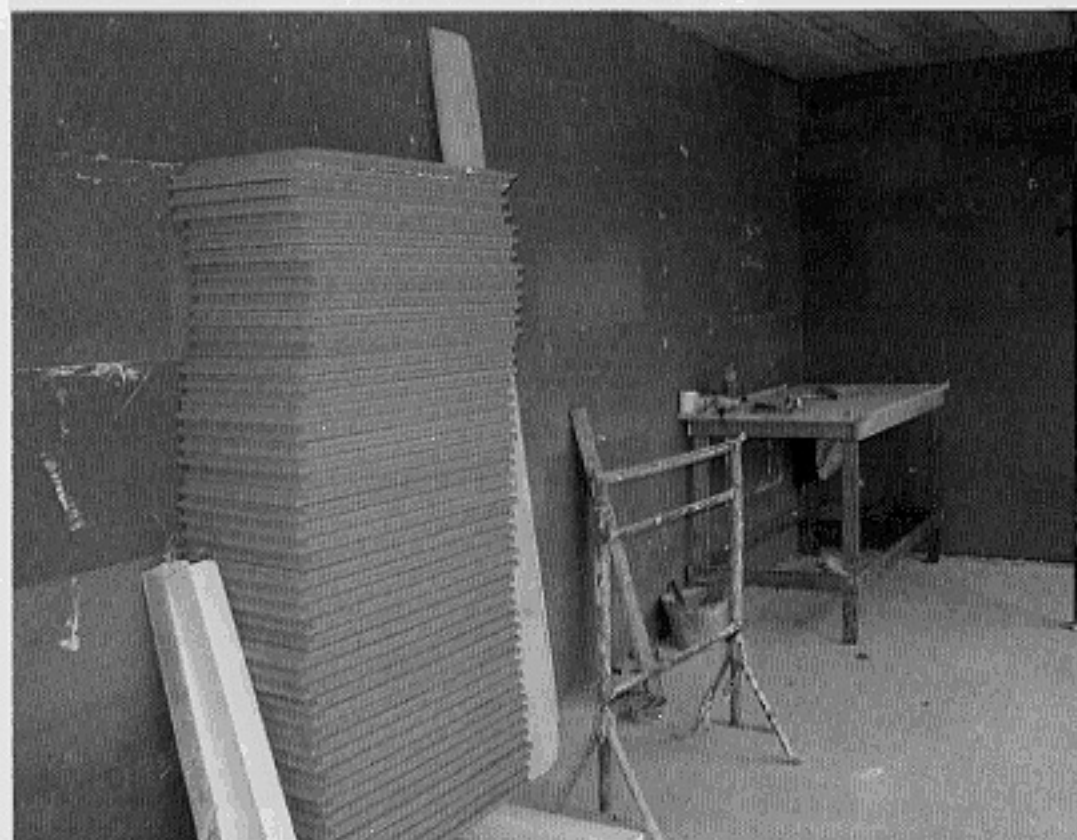
Esecuzione cappotto interno con pannelli in sughero bianco naturale supercompattato SokoTerm.LV.
