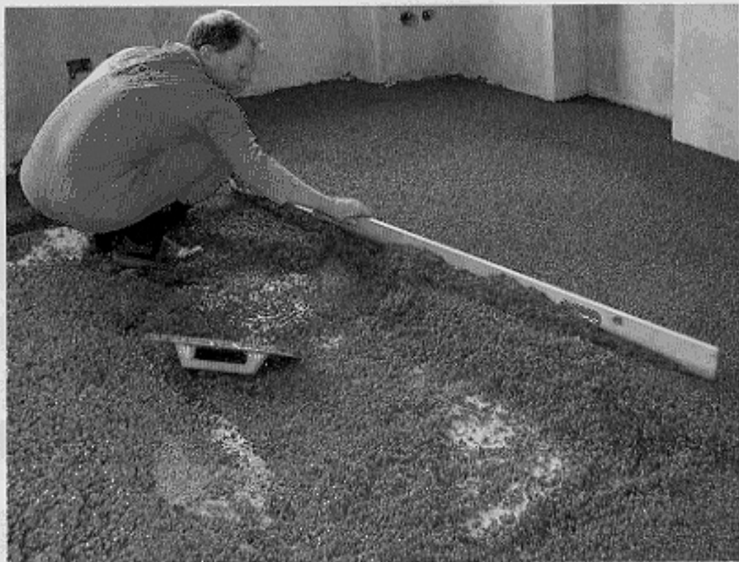
Particolare posa dell'impasto di sughero biondo naturale bollito e ventilato SugheroLite con legante a presa rapida KoGlass.
